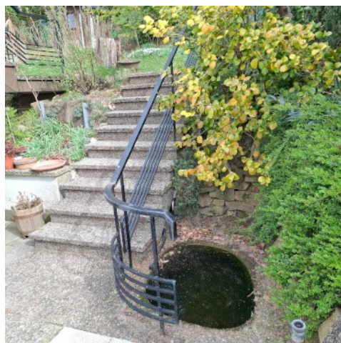
Gartentreppe (re. Regenwasserzisterne)
